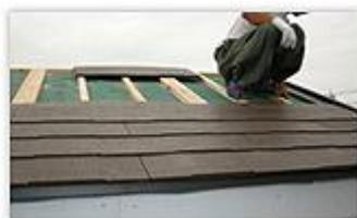
【屋根材施工状況】
